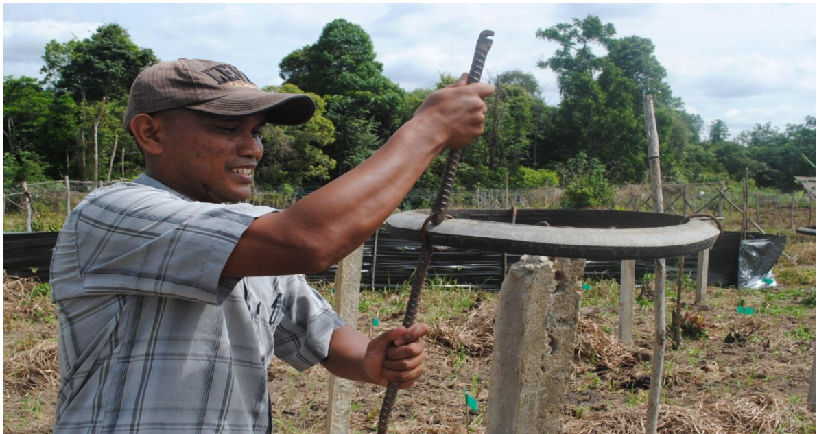
Foto 8. Pemasangan Lingkaran Ban
