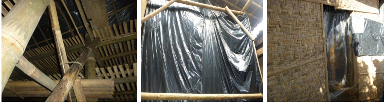
Gambar 4. Bangunan Kumbung Rangka Bambu dan Dinding Plastik
